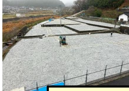
パネル敷設面に地元産石灰石を敷設し、両面パネルと組み合わせて発電効率を向上。
