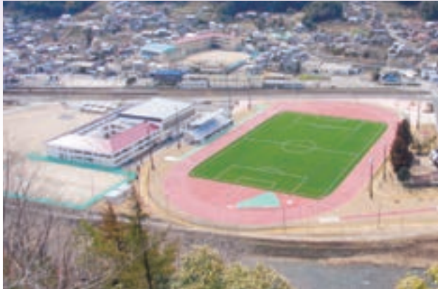
石蟹駅裏に防災拠点となる「防災公園」と新設する新見 南中学校を一体的に整備 平成23年4月竣工
