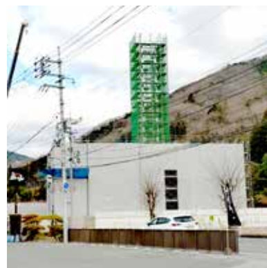
建設途中の消防庁舎 (令和7年1月現在)
