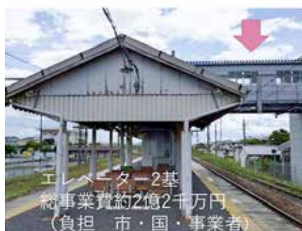
西阿知駅(倉敷市)に設置されているエレベーター
