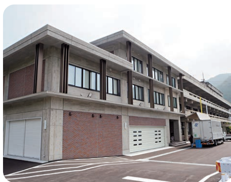
本庁舎付属棟の外観
