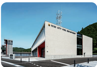
新消防庁舎の外観
