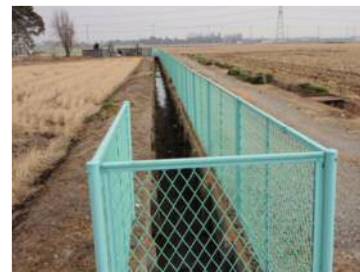
新たに設置された 金網フェンス
