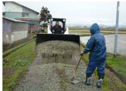
砂利の敷き均し
