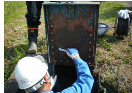
ゲートの補修状況
