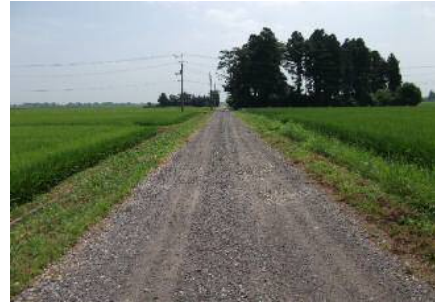
未舗装農道（砂利の路面）
