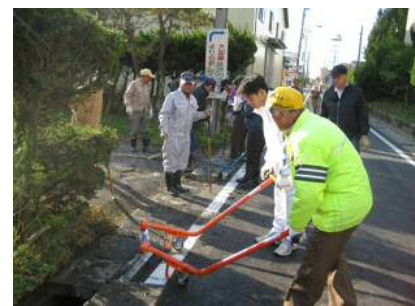
水路蓋の設置 (専用器具使用)
