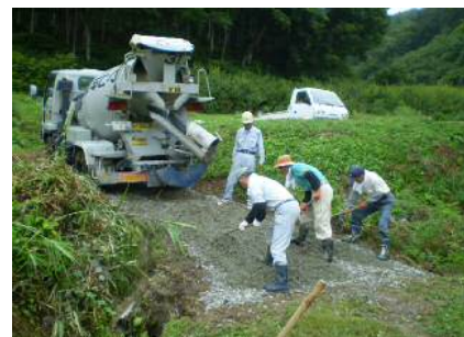
コンクリート舗装状況
