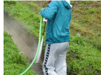
高圧洗浄機による 水路内の清掃
