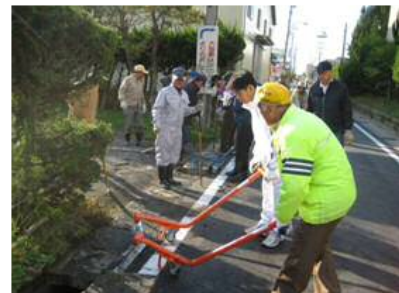
水路蓋の設置 (専用器具使用)
