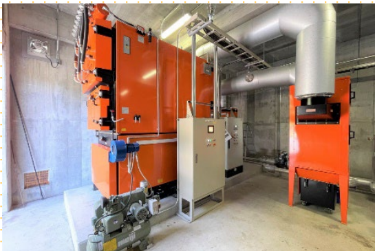
▲新見千屋温泉いぶきの里の木質バイオマスボイラー設備
