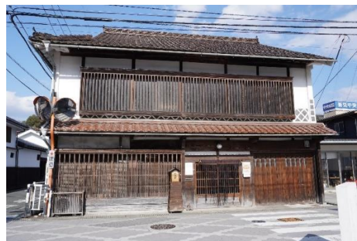
写真 1-23 旧太池呉服店店舗兼主屋（太池邸）
