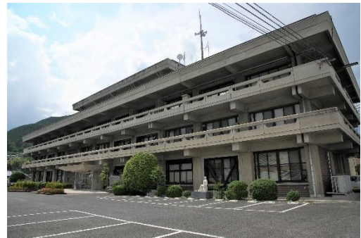
写真 1-25 新見市役所 本庁舎
