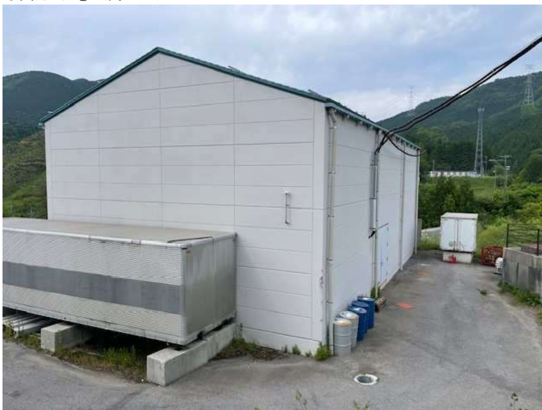
(3) 自家発電機棟 写真方向 ④ (南→北)
