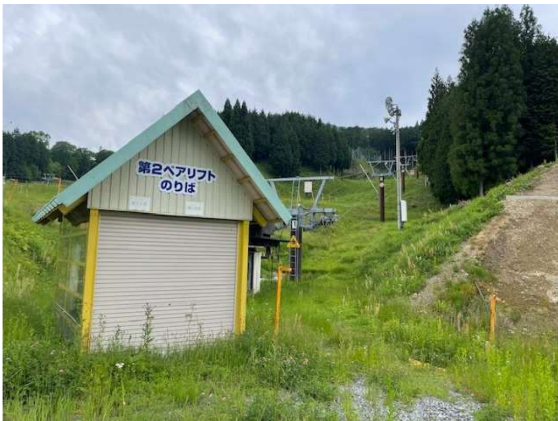
第2ペアリフト 写真方向 ⑦（北→南）
