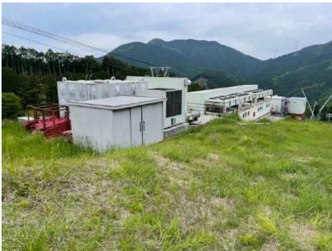
(4) 造雪機棟 写真方向 ⑤ (南→北)
