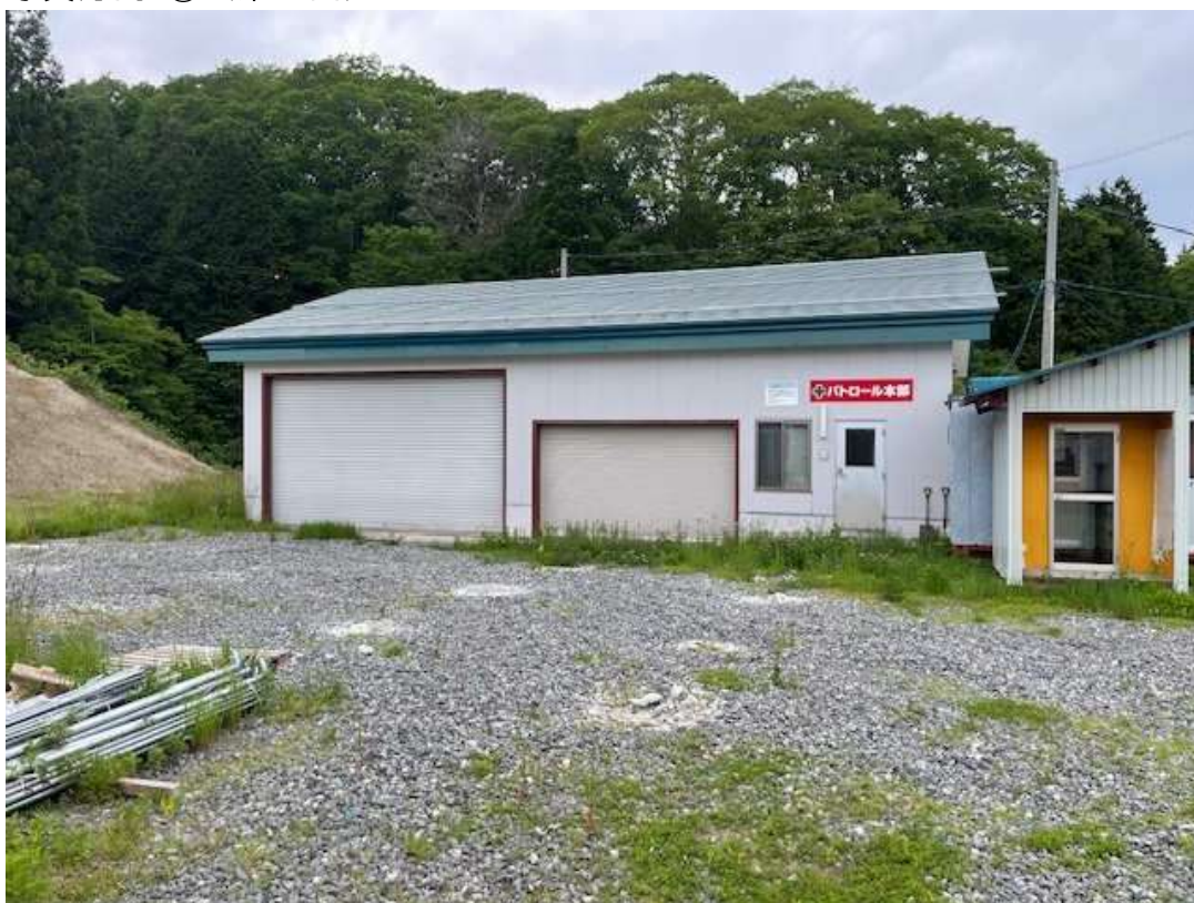
(2) 倉庫棟 写真方向 ③ (東→西)
