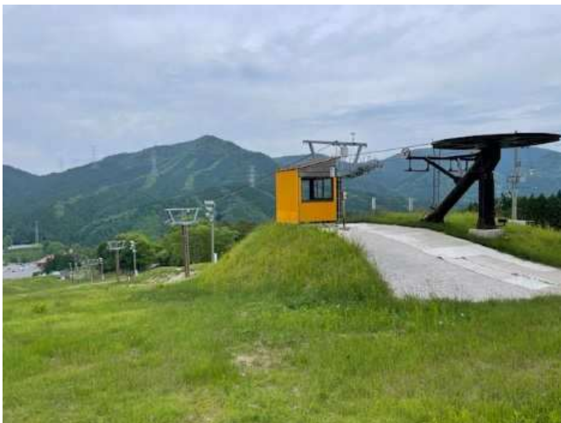
(5) 索道施設 第1トリプルリフト 写真方向 ⑥ (南→北)
