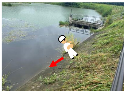
(ため池堤体の急傾斜)
