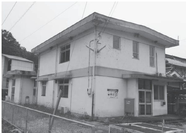
解体撤去される交流センター(西方)
