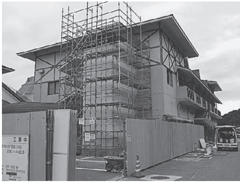
エレベーター設置工事中の新見千屋温泉いぶきの里の宿泊棟
