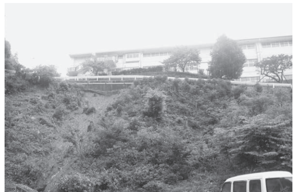
市道上市小学校線の法面
