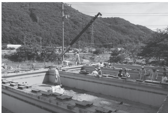
草間台簡易水道復旧の様子（ろ過池清掃）
