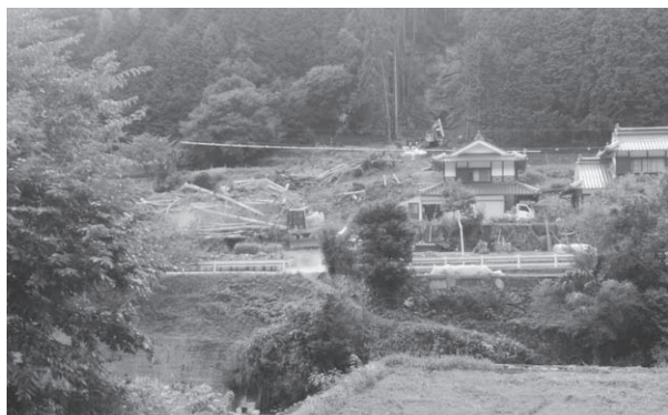
流木の撤去作業の様子（坂本）
