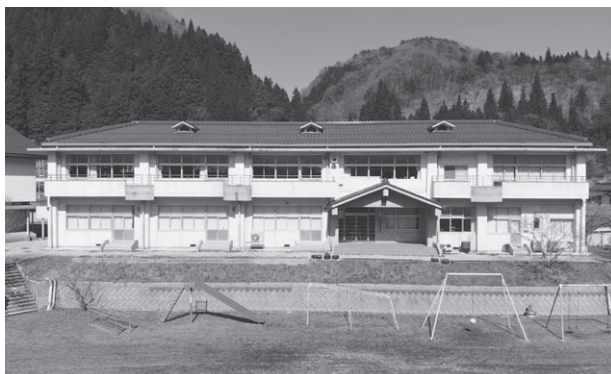
移住交流支援センター（旧油野小学校）
