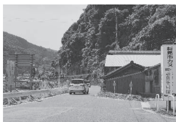
主要地方道新見日南線 新見保育所進入路付近
