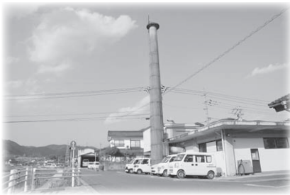
市役所本庁舎の西側にある煙突
