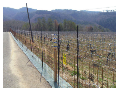
防護柵の設置状況
