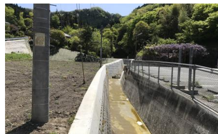
水路の復旧整備箇所
