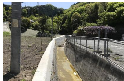
水路の復旧整備箇所
