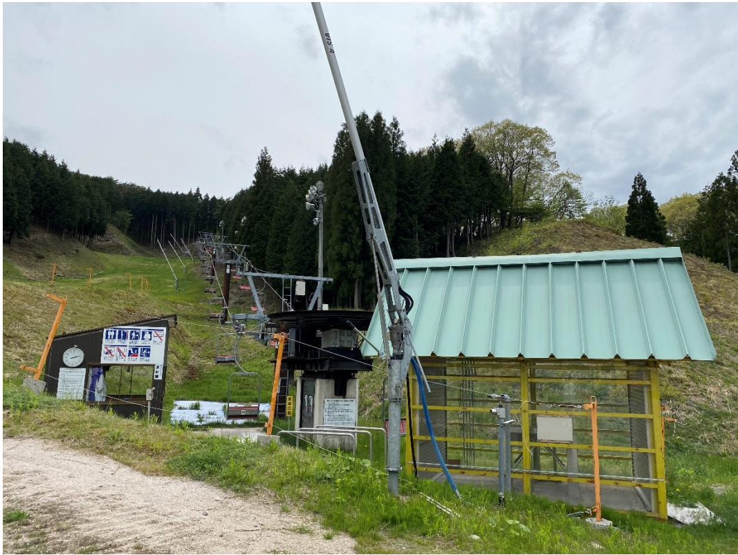
第2ペアリフト 写真方向 ⑦ (北→南)
