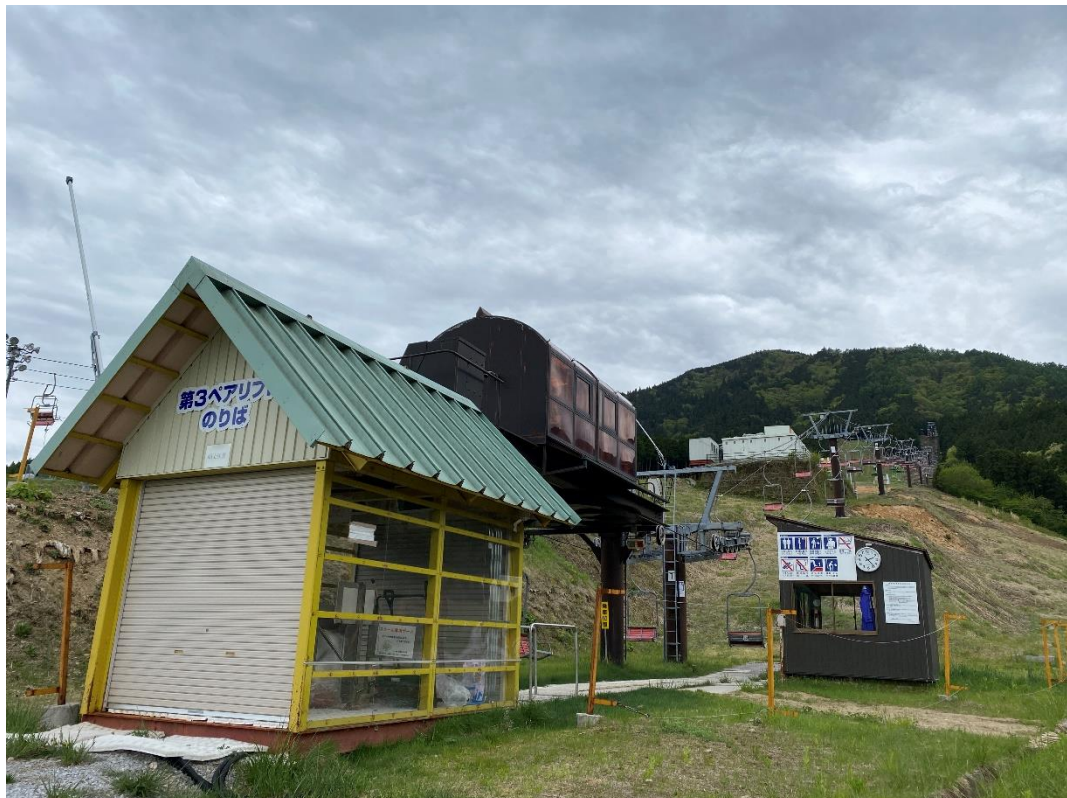
第3ペアリフト 写真方向 ⑧ (北→南)
