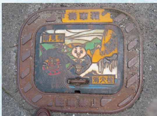
マンホール蓋
