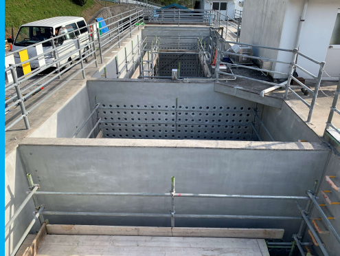
1系薬品沈殿池 (改修中)
