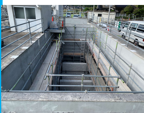
1系薬品沈殿池 (改修中)
