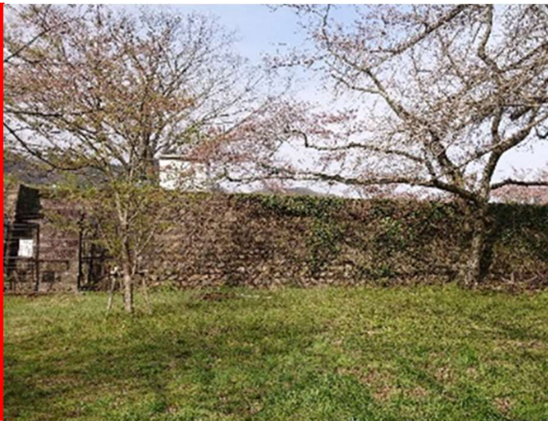
城山配水池外観（改修前）
