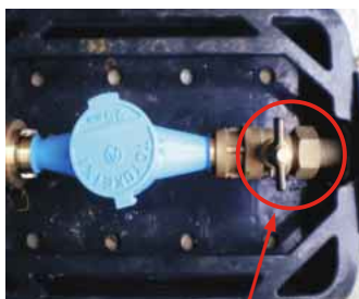
メーターボックス内止水栓 右に回すと水が止まります。
