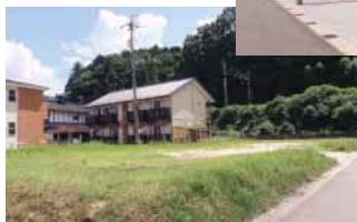
西方郷原住宅団地
