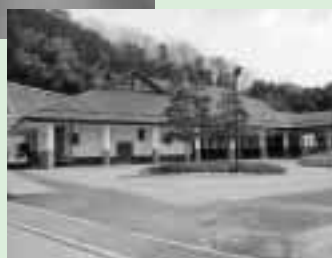
▶市営斎場の公共下水道接続工事
