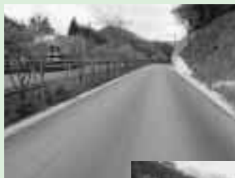
◀市道青地笹原線の改良工事
