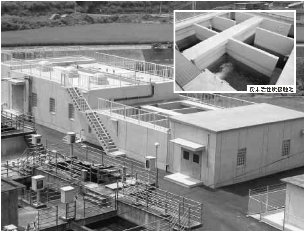
高度浄水処理施設全景
