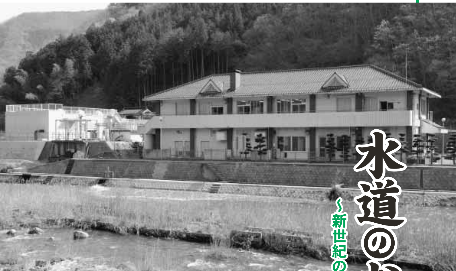
現在の馬塚浄水場全景
