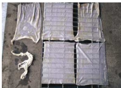
マンホールポンプにつまった水に溶けない紙
