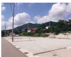
新見小岸住宅団地
