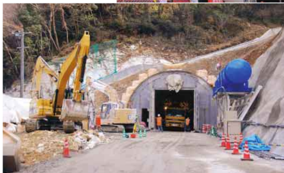
◀掘削工事の様子
