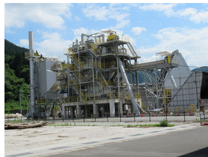
木質バイオマス発電所
