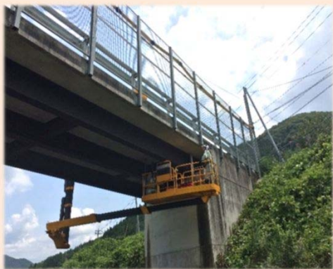
橋梁点検車による点検
