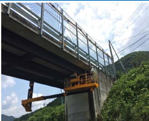
橋梁点検車による点検状況
