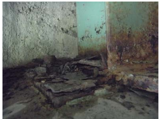
高尾中組 1 号橋
