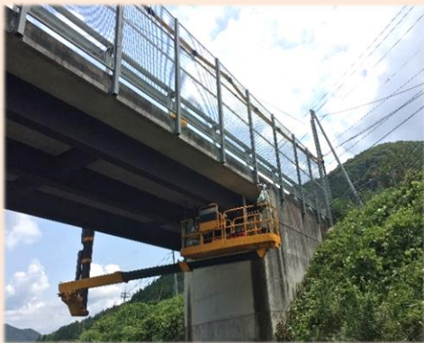
橋梁点検車による点検
