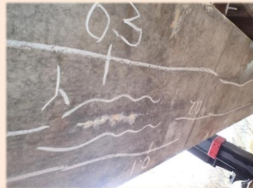
主桁のひび割れ及び遊離石灰
