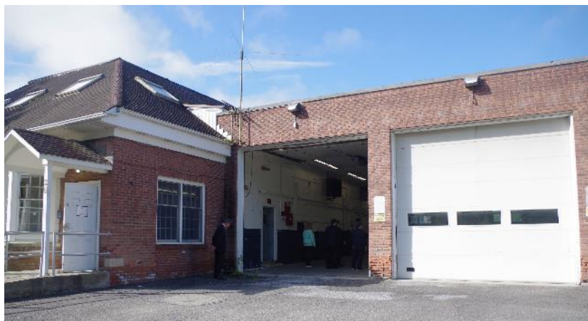
旧消防署の器具庫
